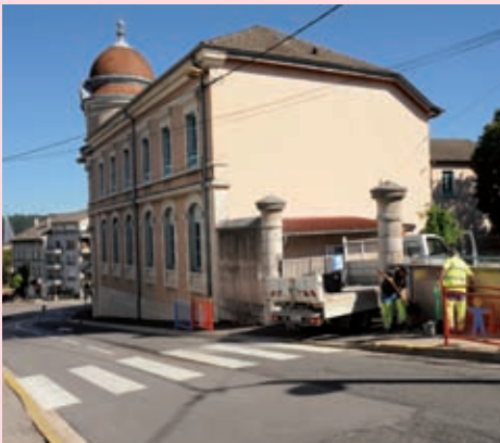
La sécurisation des abords d'écoles continue
